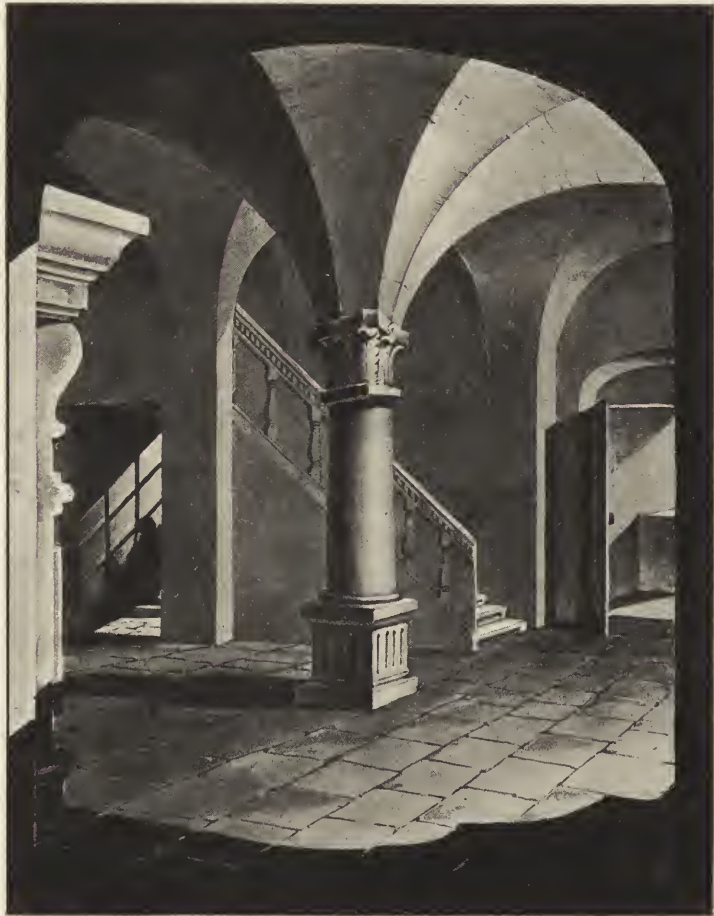
Fig. 45. Ehrenberg. Halle, Zustand vor 1874.
